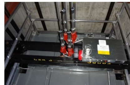
Страховальний канат з утримуючим блоком для ременя безпеки
